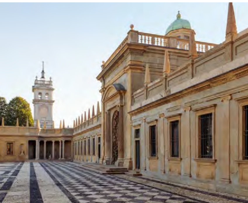
上图：在新古典主义风格砂岩宁芙神庙的北立面，能看到远处的白色水塔。水塔有一个能容纳约7,500升水的铜水箱，为所有的人工水景供水。 右图：风车阁（Windmill Court）以其中央喷泉命名。喷泉设有一个支撑
